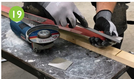
19 Ébavurer les bords coupés avec la lime douce. La lime douce doit seulement avoir été utilisée auparavant sur de l'acier inoxydable. Si elle a été utilisée sur d'autres aciers de construction classiques de moindre qualité, les bords coupés peuvent être attaqués par de la rouille erratique.
