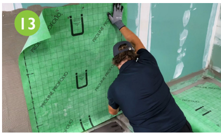
13 Étancher les surfaces murales avec la natte d'étanchéité et de désolidarisation PROFOLIO.
