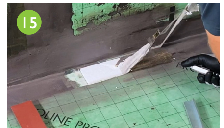
15 Enlever la protection contre la saleté du corps du caniveau.
