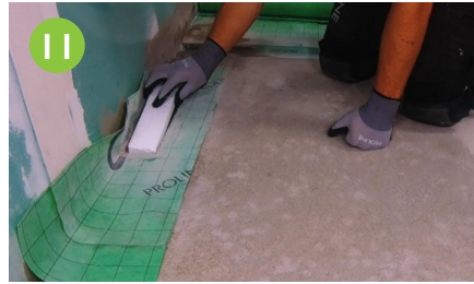
11 Insérer une protection contre les saletés dans le corps du caniveau et la fixer avec du ruban adhésif (par ex., un ruban de masquage).
