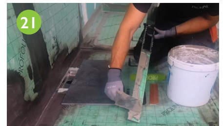
21 Appliquer de la colle à carreaux sur la face inférieure du profilé de douche de façon cunéiforme.
