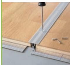
**4** Vissez maintenant, dans le profilé de base, le profilé de recouvrement du profilé de transition ou de finition.
