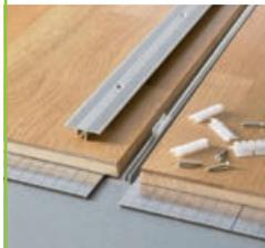
**2** Selon le comportement au retrait et à la dilatation des différents revêtements, posez les revêtements de sols sur la jointure. Si un rehaussement supplémentaire est nécessaire, les pièces fonctionnelles de rehaussement sont tout simplement insérées.
