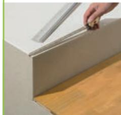
**1** Mesurez la longueur de la marche d'escalier à revêtir et découpez sur mesures le profilé de base et de recouvrement. **Conseil :** Suivant l'application, le profilé de recouvrement peut être raccourci des deux côtés. Vous obtenez ainsi une disposition des perçages régulière sur le profilé de recouvrement.
