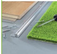
**1** Coupez le profilé de base et de recouvrement sur le même côté sur la longueur voulue. Vissez ou collez le profilé de base sur le sol. Dans le cas de chauffage par le sol, utilisez SVP une colle appropriée.
