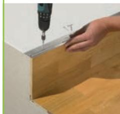
**3** Positionnez le profilé de base sur la marche et mesurez la marche et contremarche à revêtir. Transposez les mesures sur votre revêtement et découpez la marche et la contremarche à l'aide d'une scie circulaire à table et d'une scie sauteuse.
