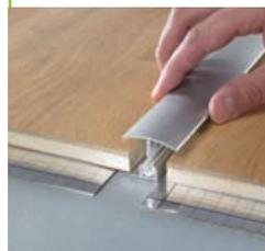
**3** Afin d'écartier légèrement l'articulation en matière synthétique située dans le profilé de base, enfoncer l'entretoise du profilé de recouvrement dans l'articulation et frapper avec le poing serré jusqu'à ce que le profilé de recouvrement repose sur les deux revêtements de sol sur toute la surface.
