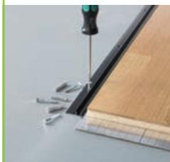
**1** Coupez le profilé de base et le profilé de recouvrement sur le même côté et à la longueur nécessaire. Vissez le profilé de base au sol. Pour les chauffages par le sol, merci d'utiliser la colle adaptée.
