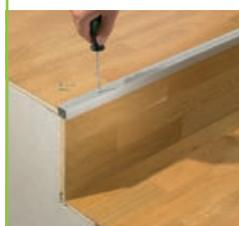
**5** Insérez le profilé de recouvrement avec l'entretoise dans la rainure du profilé de base et vissez-le au moyen des vis à tête fraisée dans des couleurs assorties qui sont incluses dans la livraison.
