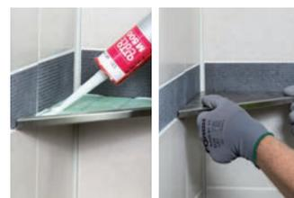
OTTOCOLL M 500 oder Fliesenkleber auf der befliesbaren Fläche des PROSHELFS auftragen. Danach die auf Maß geschnittene Fliese einsetzen.
