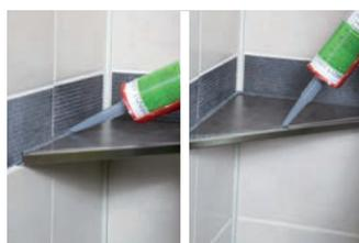
Die neu entstandenen Fugen dauerhaft mit neutral vernetzendem Silikon versiegeln.
