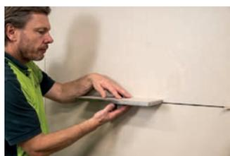
Die Fliese passend zuschneiden und einkleben. Verfugen und nach Trocknung die Silikonfuge einbringen.
