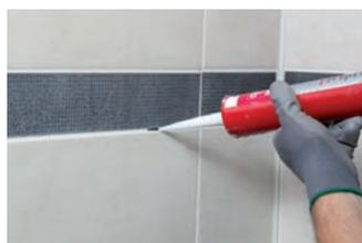
OTTOCOLL M500 Hybrid-Kleber- und Dichtstoff in den gesäuberten Fugenspalt einbringen.
