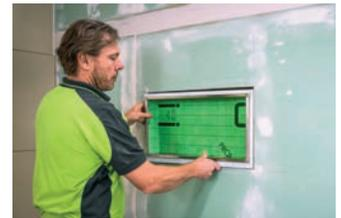
Mit geeignetem Material PROBOX einkeilen, einmessen und ausrichten.
