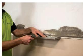
Überschüssigen Fliesenkleber im Einbaubereich entfernen. PROSHELF mit den unterseitigen Schenkelflächen hinter die Fliese einschieben.
