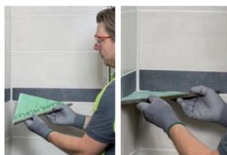
PROSHELF in den mit Kleber befüllten Fugenspalt einsetzen (leichtes Gefälle nach vorne wird empfohlen).
