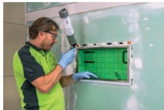
Nach Aushärtung der Fixpunkte verfüllen und den Montageaum ausspachteln.
