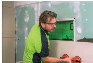
PROBOX-Leibungen, Ablage und Deckel sowie Rückwand einmessen und Fliesen verlegen.
