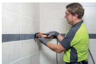
Fuge mit geeignetem Werkzeug (z. B. Winkelschleifer) entfernen und reinigen.
