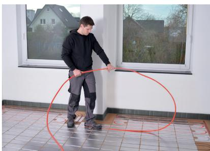
Metallverbundrohr in einem großen Bogen von oben spannungsfrei in die Rillen drücken. Maximale Heizkreislänge 120 m.
