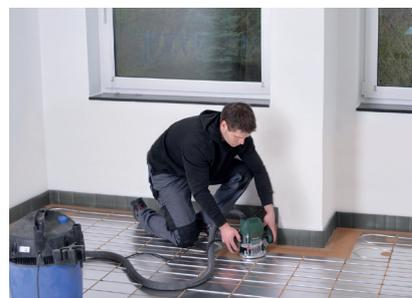
Individuelle Rohrführungen werden mit einer Oberfräse erstellt. Verwendung eines Staubsaugers ist empfehlenswert.
