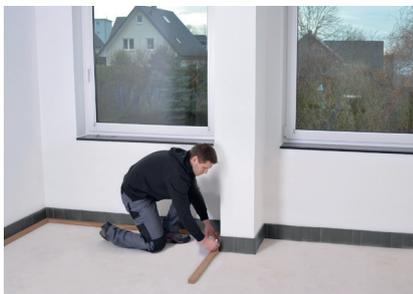
Randdämmstreifen und den ersten Rahmenträger auf sauberen, tragfähigen Untergrund verlegen. Rahmenträger auf Boden verkleben.
