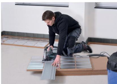
Nach Bedarf die Heizelemente zwischen den Wärmeleitblechen zuschneiden. Niemals Aluminiumbleche schneiden!
