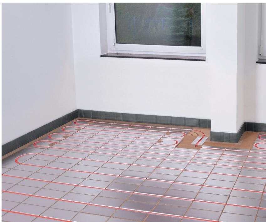
Auf dem Bild oben sehen Sie die fertig verlegte Fläche mit NatureLine. Um die verlegten Elemente und das Rohr zu schützen, sowie die Oberfläche zu stabilisieren wird zum Schutz die PROSECUREfibretec 2.0 mit PROFIX Dispersionsfixierung vollflächig verklebt. Die folgenden Verlegeschritte finden Sie in unseren Systemaufbauten.
