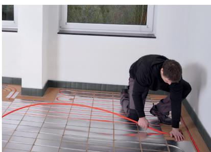
Direkt nach den Kopfelementen das Metallverbundrohr in beide Richtungen biegen um Spannung abzubauen.
