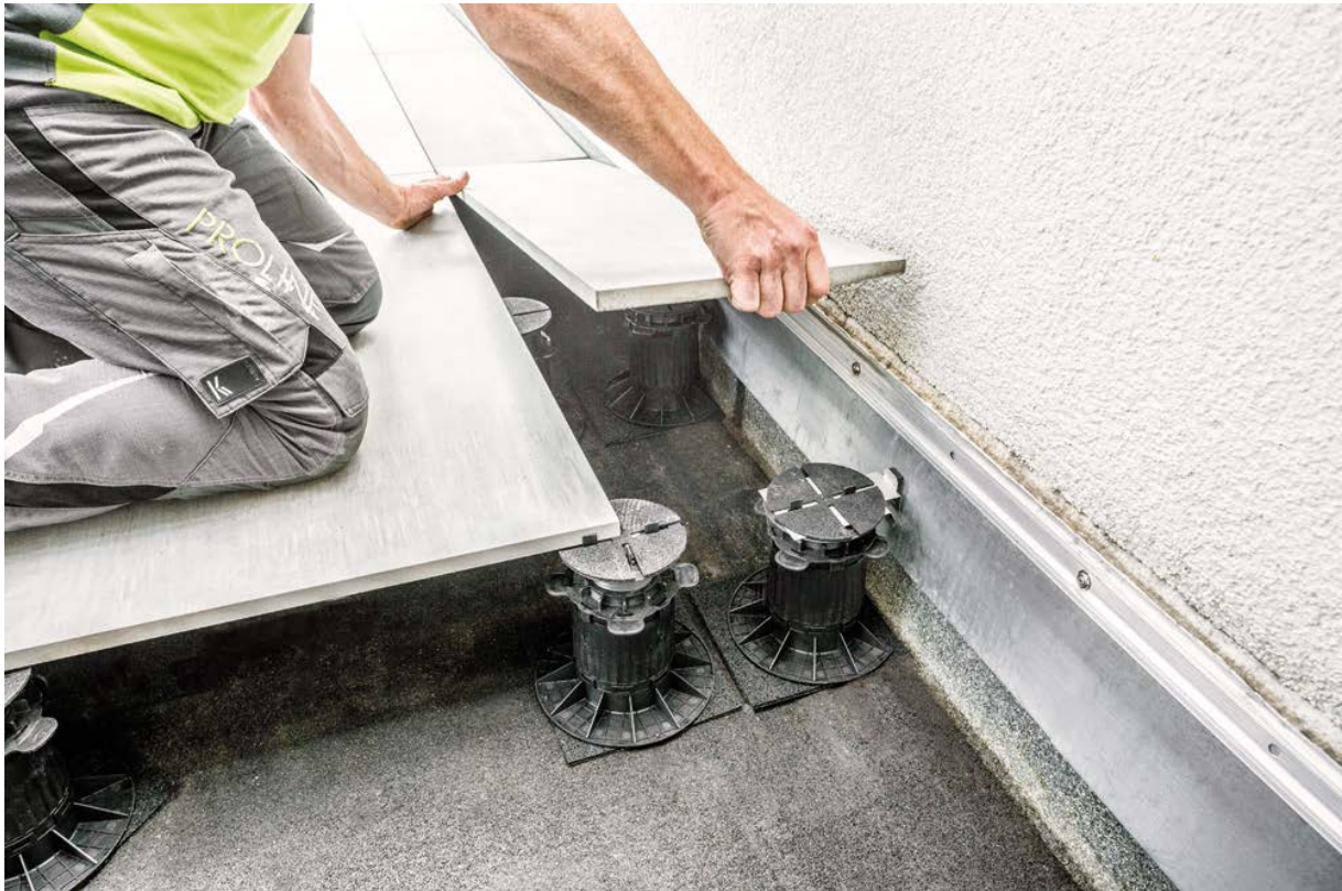
BU: Sichere Verlegung von Outdoor-Keramik und Naturstein auf Dachterrassen mit PROSTILT
