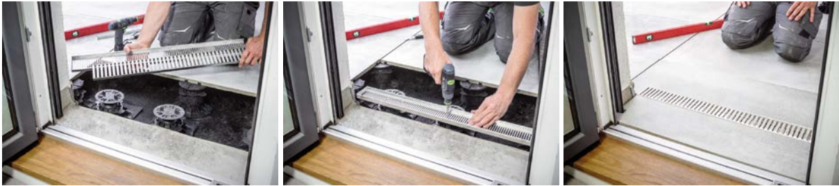
BU: Verlegung des PROSTILT-Rinnensets nach DIN18040-2
