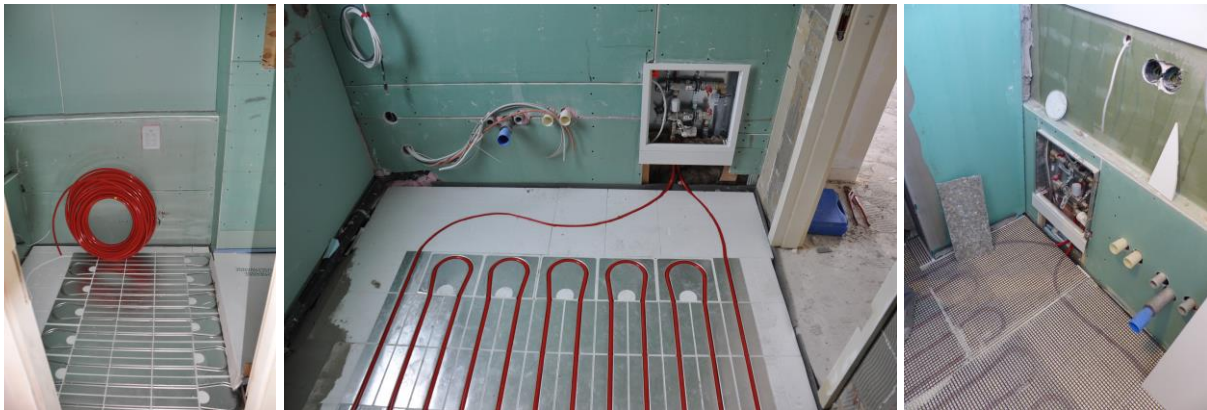
BU: Installationsprozess der Proline ENERGY Flächenheizung in den SI-Suites, Stuttgart
