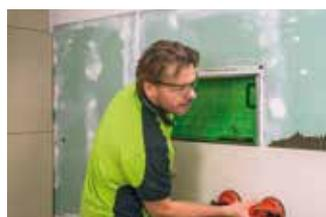
Mesurer l'ébrasement, la tablette et le couvercle de la PROBOX ainsi que la paroi arrière et poser le carrelage.
