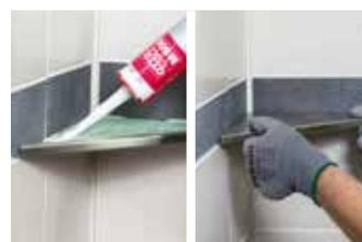
Appliquer OTTOCOLL M 500 ou de la colle à carreaux sur la surface carrelable de PROSHELF. Poser ensuite les carreaux coupés aux dimensions requises.
