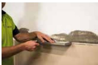
Enlever l'excédent de colle à carrelage dans la zone d'installation. Insérer PROSHELF avec les surfaces inférieures derrière le carrelage.
