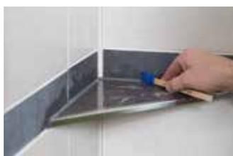
Traiter et lisser les joints de silicone avec un lisseur de joint approprié.
