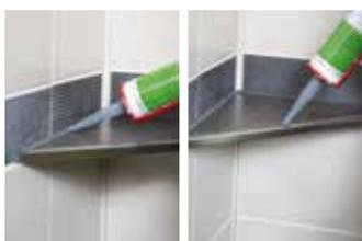
Étancher les nouveaux joints avec un mastic silicone monocomposant élastique.
