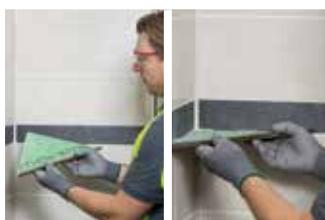
Insérer PROSHELF dans le joint rempli de colle (une légère déclivité vers l'avant est recommandée).
