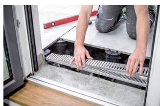
Adapter la grille du caniveau et l'ajuster avec la vis de réglage, si nécessaire.
