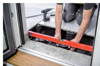
Régler ensuite les pieds de réglage PROSTILT à la hauteur correcte en effectuant l'ajustage fin à l'aide de la vis de réglage.
