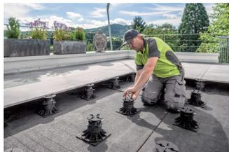
Le filetage sous le plateau d'appui des dalles permet d'ajuster rapidement le pied de réglage à la hauteur souhaitée.
