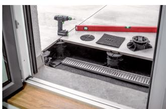
Pour réaliser un passage sans barrières, il convient d'utiliser le set de caniveau PROSTILT.
