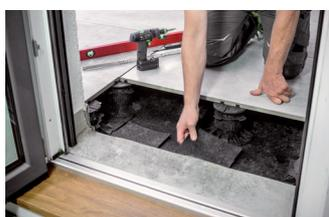
Positionner le tapis de caoutchouc granulé sur le support.
