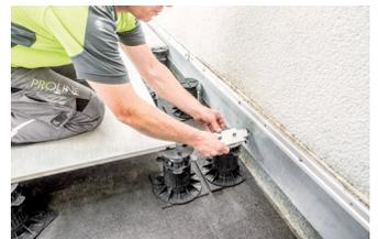
La pose du clip d'écartement PROSTILT avec pad en néoprène est nécessaire pour empêcher le glissement de la dalle vers le mur.
