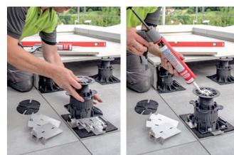
Pour réaliser l'angle, il convient de couper le pied de réglage sur deux côtés et d'enlever les écarteurs de joint. Coller le composant avec la colle PU.
