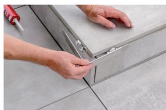
La colle PU doit être appliquée sur la languette de réception du clip supérieur PROSTILT pour accrocher l'angle sortant PROSTILT.
