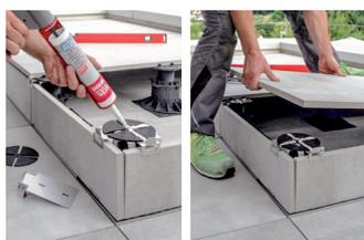
Pour réaliser l'angle, il convient de coller un second clip supérieur PROSTILT par superposition à un angle de 90°. Fixer le tapis de sécurité PROSTILT avec de la colle PU.
