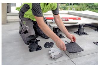
Les composants des solutions de recouvrement et d'angles extérieurs doivent être collés entre eux en supplément avec de la colle PU pour empêcher un glissement sous charge.
