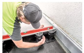
L'ajustage fin s'effectue à l'aide de la grande vis de réglage du pied de réglage.
