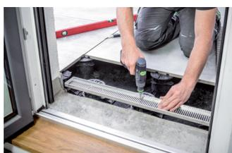
Poser le corps du caniveau contre les écarteurs de joints horizontaux et le fixer par vissage.
