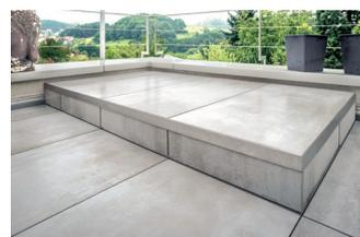
Accrocher le profilé de recouvrement PROSTILT et fixer temporairement l'ensemble de la solution de recouvrement avec un ruban adhésif adéquat. Le ruban adhésif peut être enlevé après le durcissement de la colle PU.
