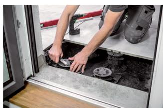
Positionner le pied de réglage PROSTILT avec le bord coupé dirigé vers le mur. Dans ce cas de figure, il convient d'enlever les écarteurs de joint perpendiculaires au mur.
