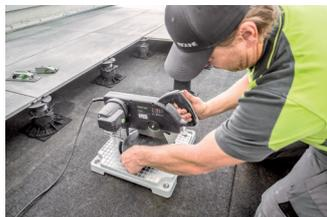
Pour effectuer le raccordement au mur, les pieds de réglage PROSTILT doivent être sciés le long de la ligne prémarquée sur la face arrière.
