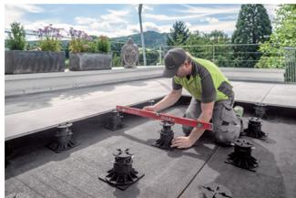
L'utilisation de la nivelle est requise pour transférer la hauteur exacte sur le pied de réglage voisin. L'ajustage fin s'effectue à l'aide de la grande vis de réglage du pied de réglage.
