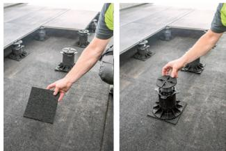
Placer d'abord le tapis de caoutchouc granulé sur le support, positionner ensuite le pied de réglage sur celui-ci et poser ensuite le tapis de sécurité sur le pied de réglage.
