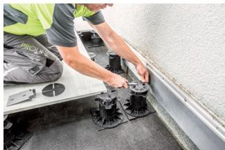
Le pied de réglage peut ainsi être positionné parfaitement au niveau du mur et les écarteurs pour le joint transversal peuvent être enlevés par cassure ou coupe.
