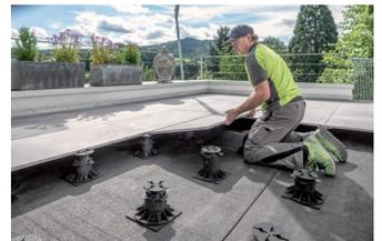
Poser ensuite la plaque et ré-effectuer le réglage en hauteur à l'aide de la grande vis de réglage et une nivelle.
