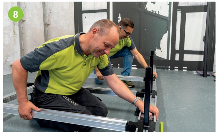
Einen Verbund durch Aufschieben der Basisträger auf die Längsträger herstellen. Verbindungspunkte mit Bohrschrauben oben und seitlich verschrauben (siehe Bild 2 + 3).
