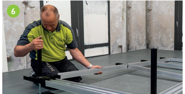
Durch aufschieben der Basisprofile auf die seitlichen Laschen erfolgt die Verbindung mit den Längshaltern.
