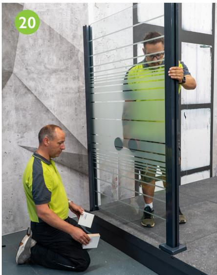
Montageklötze entfernen und Element ablassen.
