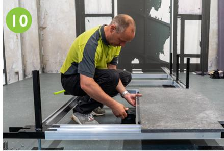
Feldbreite beachten. Bei zu großer feldbreite Querträger einfügen und durch Stellfuß unterstützen.
