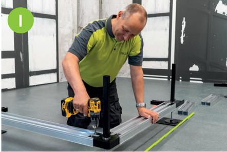
Beim Aufbau eines Sicht-, Wind- und Lärmschutzes benötigt man zur Montage des Pfostensystems Eck- und Längshalter. Umlaufend wird das PROSTILTadvance Basisprofil doppelt nebeneinander montiert. Zum Höhenausgleich Gewindefüße von unten in die Pfostenhalter eindrehen.
