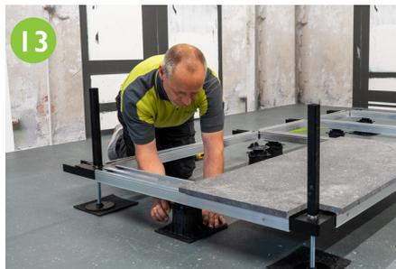
Die Positionierung der Stellfüße ist abhängig von Feldbreite, Nutzlast und Spannweite.
