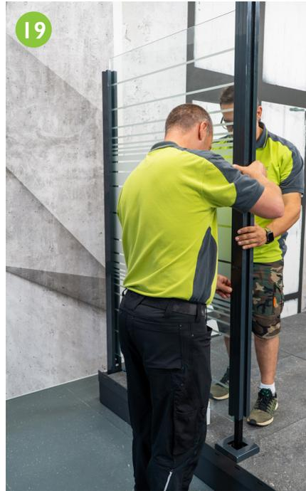
Zweiten Pfosten auf Anker schieben und ebenfalls vor unterem Endpunkt auf den Durchschruttschutz eine Gummikappe montieren.
