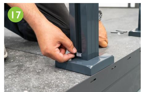
Gummiklappe auf Durchrutschschutz montieren.
