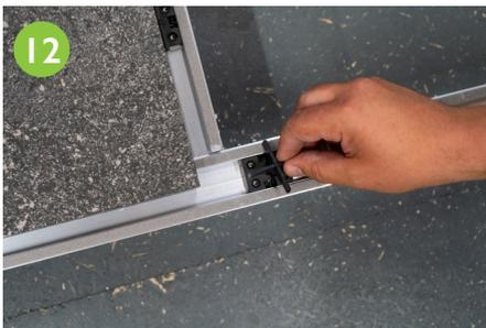
Um ein verrutschen des Belages zu verhindern, wird ein PROSTILTadvance Multiclip X in das Basisprofil eingelegt, an den verlegten Belag geschoben und verschraubt. Die Fugenstege des Multiclip X können mittels einer Gehrungsschere (Artikelnummer 94900) situationsbedingt angepasst werden.
