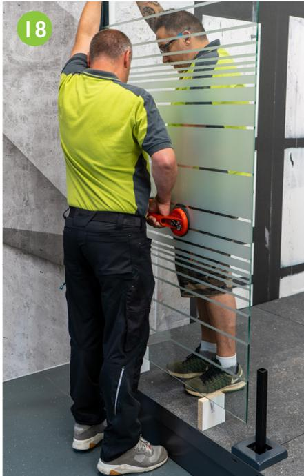
Beim Einbau der Sichtschutzelemente zuerst Montageklötze positionieren. Element in den Pfosten schieben und auf Montageklötze absenken.
