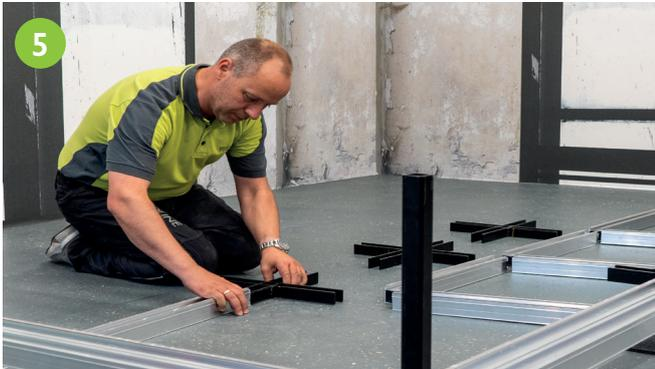
Die Verbindung der Längs- und Querträger erfolgt durch Kreuzverbinder, die an den Schnittpunkten der Basisprofile angesetzt werden.
