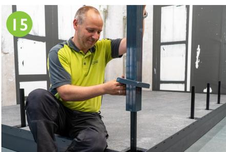
Universalpfosten mit aufgeschobener Abdeckklappe auf Eckträger aufsetzen.
