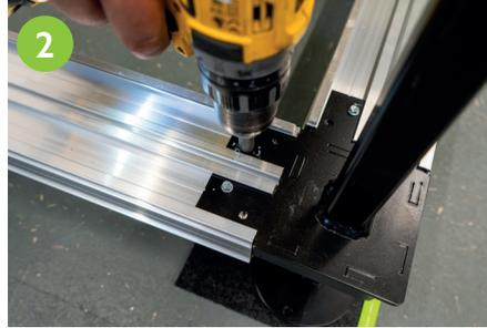
Basisprofile auf gewünschte Länge bringen. auf seitliche Laschen der Eck- und Längshalter schieben und von oben verschrauben. Verwendung finden hier PROSTILTadvance Bohrschrauben 5,5 x 25 mm mit 6 KT Flansch V2A. Passendes Werkzeug: PROSTILT Steckschlüssel E 6,3 SW 8 mm.
