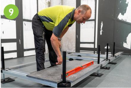
Bei der Verlegung des gewählten Belages PROSTILTadvance Soft Tape zur Trittschalldämmung und Auflageschutz auf Basisprofil PROSTILTadvance aufkleben. Ausrichten der Konstruktion durch Justierung an Stell- und Gewindefuß.
