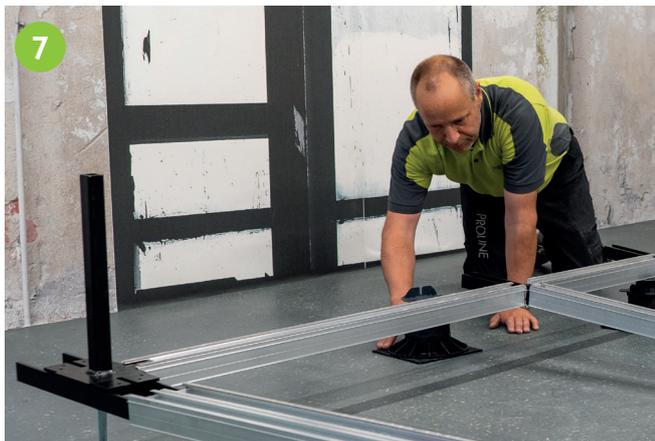
Zum Höhenausgleich PROSTILTadvance Stellfuß Basic+ U als Montagehilfe unter den Kreuzverbindern positionieren.
