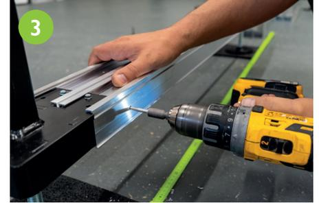
Seitliche Verschraubung. Verwendung finden hier: PROSTILTadvance Bohrschrauben 5,5 x 25 mm mit 6 KT Flansch V2A. Passendes Werkzeug: PROSTILT Steckschlüssel E 6,3 SW 8 mm.
