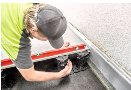
L'ajustage fin s'effectue à l'aide de la grande vis de réglage du pied de réglage.
