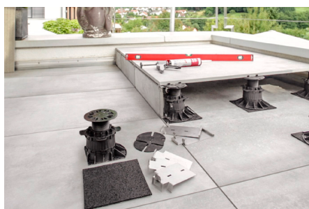
Pour réaliser une marche, il convient d'utiliser les clips supérieurs et inférieurs. Le montage requiert une colle PU en supplément.
