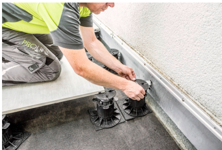
Pose du tapis de sécurité.
