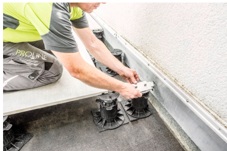
La pose du clip d'écartement PROSTILT avec pad en néoprène est nécessaire pour empêcher le glissement de la dalle vers le mur.
