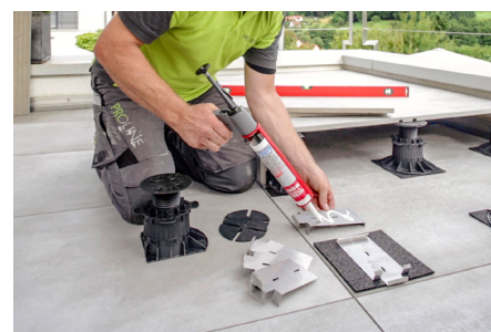
Coller le clip inférieur PROSTILT sur le tapis de caoutchouc granulé à l'aide de colle PU. Pour réaliser l'angle, il convient de coller un se-cond clip inférieur par superposition à un angle de 90°.
