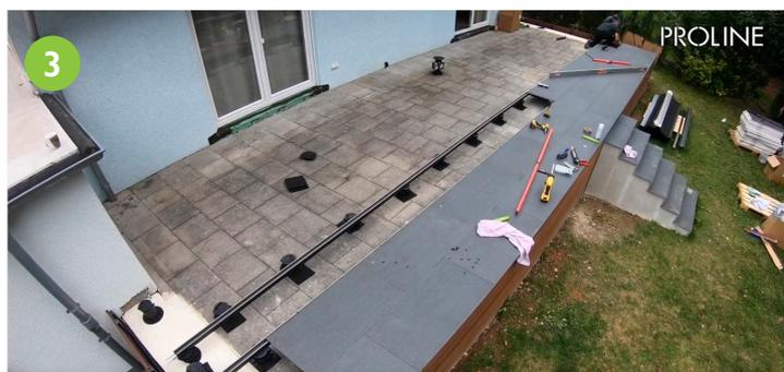
Il convient maintenant de poser les rangées de dalles l'une après l'autre. Cette méthode de montage est avantageuse, car elle permet d'effectuer des corrections sur l'axe longitudinal des profilés de la sous-construction lors de la pose du revêtement supérieur.
